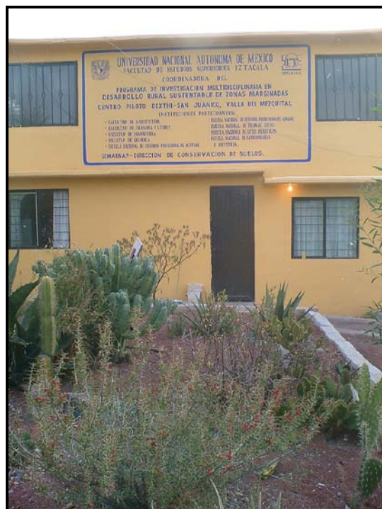
Foto 3. Fachada del Centro Piloto de la U.N.A.M.
