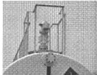
**Figura # 11.9. Válvula de venteo y arrestador de flama**
