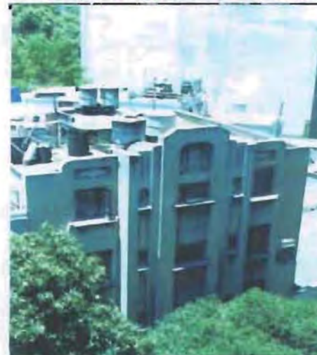
Foto 115. Edificio de vivienda (Autor desconocido década de los treinta) ubicado en la Av. Sonora, de estilo "Art-Déco" frente a la tienda departamental "Suburbio". Inmueble catalogado por el INBA.
