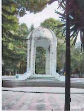
Foto 78. Glorieta Popocatepetl, los pavimentos están deteriorados, la vegetación es muy densa y no tiene mantenimiento, la fuente tiene un buen estado de conservación y conserva el concepto original.
