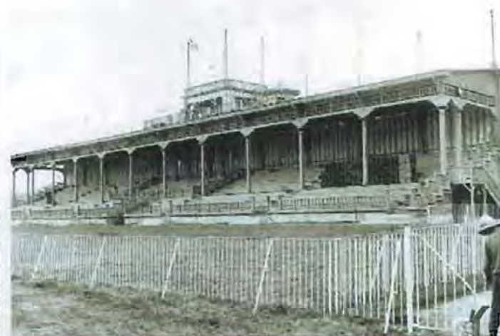
Foto 15 Vista de las tribunas del hipódromo, antes de la inauguración. 23 Octubre de 1910
