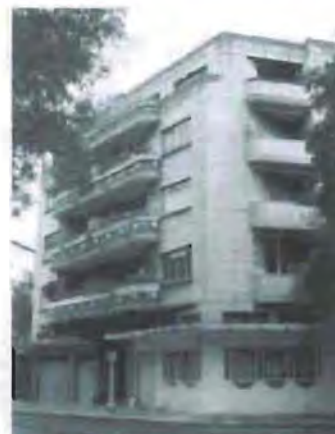
Foto 109. Edificio de vivienda y comercio menor, (autor desconocido década de los cuarenta) De estilo "Art-Déco" por la época en que se construyó pertenece a la corriente de "Stream line". Inmueble catalogado por el INBA.
