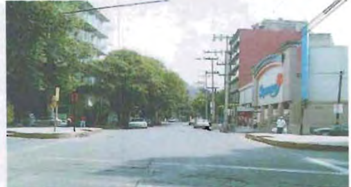
Foto 71. Av. Michoacán el constante cambio uso de suelo que ha sufrido la zona se ve aquí como un claro ejemplo de desorden urbano, ya que encontramos comercios donde la imagen corporativa predomina sin importar el contexto, aunado a que se han construido edificios de más de 4 niveles como los que se habían propuesto en los inicios de la colonia Hipódromo
