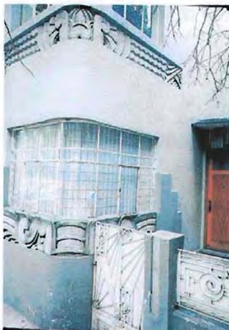
Foto 24 Casa ubicada en Av. Amsterdam 206, se pueden apreciar los detalles conformados por relieves geométricos decorativos, y el magnífico trabajo en la herrería característicos de la corriente Déco.
