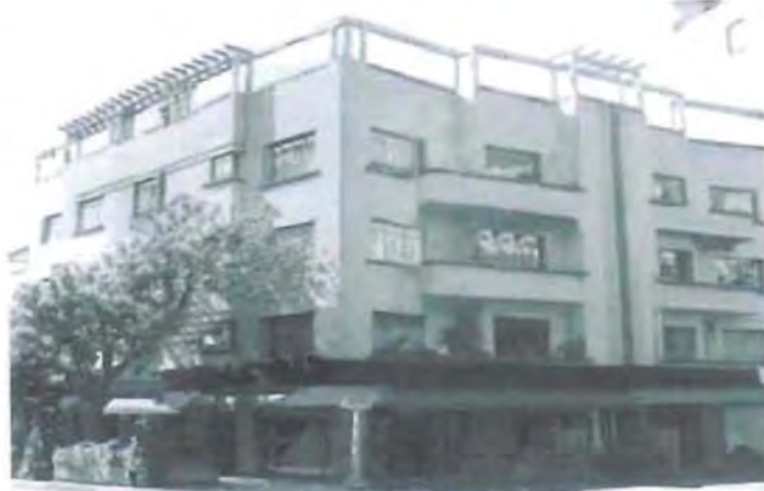
Foto 102. Edificio de vivienda con comercio menor, (autor desconocido década de los treinta) ubicado en Amsterdam 241. Inmueble catalogado por el INBA.
