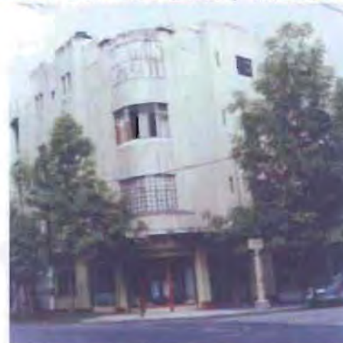
Foto 119. Edificio Amsterdam. (autor desconocido década de los treinta). Picado en Av. Amsterdam 154 esquina con Ozuluama. De gran parecido al edificio Confort. De estilo "Art-Déco" perteneciente a la corriente "Stream Line". Inmueble catalogado por el INBA.
