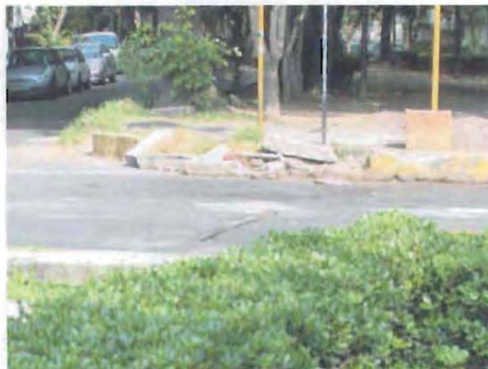
Foto 89. Las puntas de camellón se ven seriamente dañadas por la presencia de raíces agresivas, por el descuido de los conductores del sistema de limpieza de la ciudad, la comunidad conoce la problemática pero no toman soluciones. Deterioro de la imagen urbana
