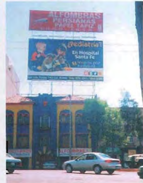
Foto 34 El uso comercial que han adquirido algunos edificios de la colonia los ha obligado a adaptar sus plantas bajas para locales comerciales y soportar en sus azoteas enormes anuncios que en algunos casos sobrepasa la altura de los inmuebles. 3
