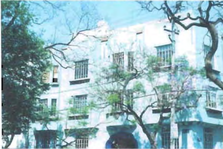
Foto 126. Edificio habitacional (autor desconocido, década de los treinta). De estilo "Art-Déco". Ubicado en la Av. México esquina con Parras.
