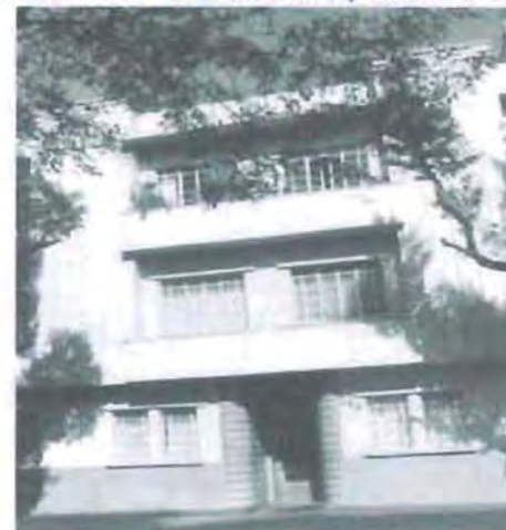
Foto 103. Edificio de vivienda (autor desconocido 1940), ubicado en Av. Ámsterdam 252, característica más importante es que el acceso es "Art-Déco" y se encuentra en medio lo que hace que se seccione el rodapié, y la fachada evoca las muy comunes terrazas. Inmueble catalogado por el INBA.
