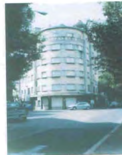
Foto 101. Edificio Lafayette, (1934). Ubicado en la calle de Cuitlápetl No. 36, es uno de los edificios más importantes de la colonia, es un remate visual visto desde la glorieta del Cuitlápetl, misma que se integra a la Av. Amsterdam. Catalogado por el INBA
