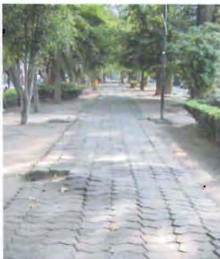
Foto 88- Los pavimentos se ven seriamente dañados por las raíces de las especies que viven en el camellón, además de la contaminación del suelo por materia orgánica.
