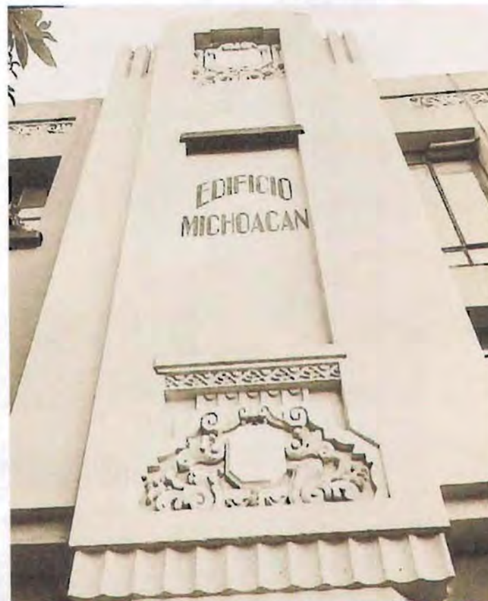
Foto 08 Detalle en fachada del Edificio Michoacán estilo Art Déco Arq. Ramón Llano Suárez, calle Michoacán 54 esq. Nuevo León ((1932)
