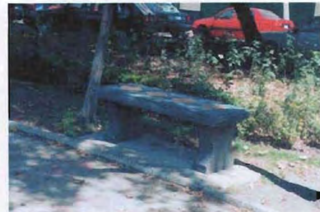
Foto 48 Banca de concreto con recubrimiento de recinto y losetas de barro recocido, ubicada en la Plaza Popocatepetl. Estas fueron colocadas en los años cincuenta, aproximadamente
