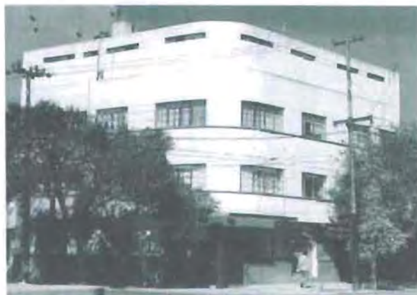
Foto 120. Edificio Niza (José Creixelm. Y Enrique de la Mora, 1934) ubicado en Av. Amsterdam 73 esquina Parras. De gran importancia por quienes lo construyeron, pertenece al movimiento "Moderno" mas específicamente al bloque "Purista". Inmueble catalogado por el INBA.
