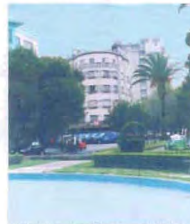
Foto 97 Edificio Lafayette, una de las máximas expresiones plásticas de la arquitectura estilo "Art Déco. El contexto arquitectónico de la colonia contribuye a darle identidad al zona, no solo por la belleza de las fachadas sino porque importantes arquitectos de la época dejaron plasmada aquí su obra
