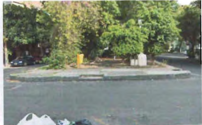
Foto 73. Av. Amsterdam conserva su traza original, conformada por un circuito de 15 secciones las cuales manifiestan señales serias de abandono en banquetas y básicamente en el camellón, un bajo nivel de conservación, la abundante vegetación sin mantenimiento, los problemas en los pavimentos viejos y rotos, la constante contaminación en los suelos, el vandalismo que sufren constantemente el mobiliario urbano han llevado a esta vialidad a una lamentable y deteriorada imagen urbana.
