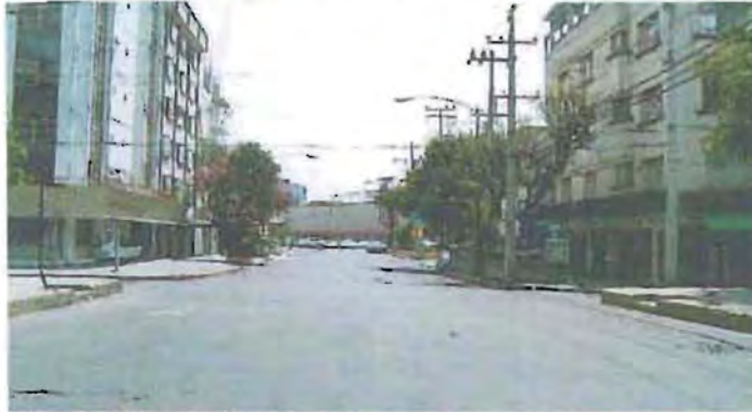
Foto 70 Av. Michoacán, vista desde el camellón de Amsterdam hacia la Av. de los Insurgentes. Es una de las calles más impotentes de la estructura vial de la colonia Hipódromo, y la que tiene más deteriorada a la imagen urbana, debido a que es una zona comercial donde los restaurantes han modificado la imagen a su favor, sin importar que sus adecuaciones rompan con el contexto de la zona.
