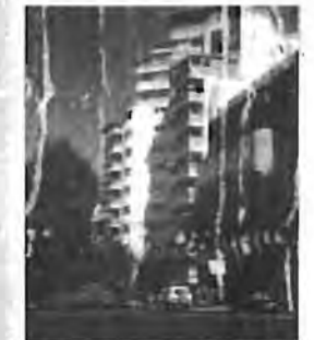
8 Edificio habitacional de estilo "Art-Déco" de la corriente "Stream-Line" Ubicado en la Av. México.
