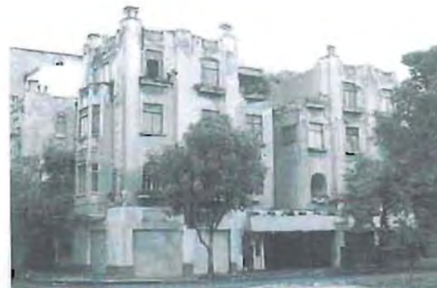
Foto 105. Edificio Casa Jardines (Arq. Juan Serrano 1930), Ubicado en Av. Ámsterdam 285, es de estilo "Art Déco" poco convencional para su estilo pero es de gran importancia para la arquitectura mexicana. Inmueble catalogado por el INBA.
