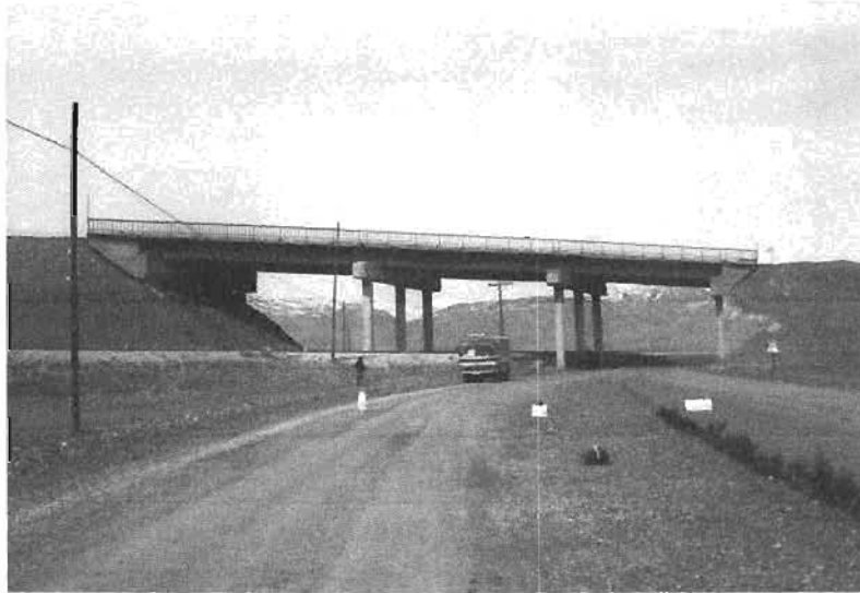
Fig. 3.3 Puente para el paso del tren
