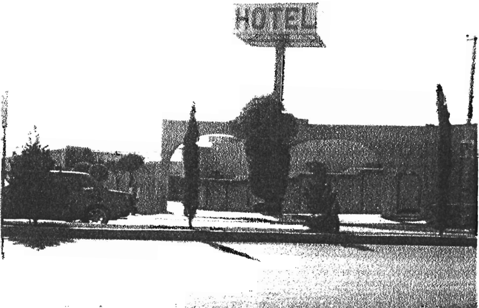
Equipamiento (Q) foto 5
