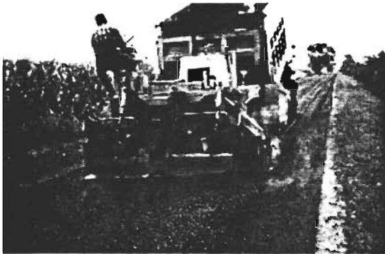
Figura 2.6 Adición de hule reciclado en la pavimentación de carreteras 41 .
