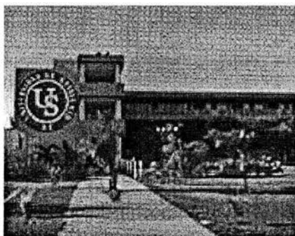
Figura. 2.2 Edificio. Universidad de Sovento AC Campus Coatzacoalcos
