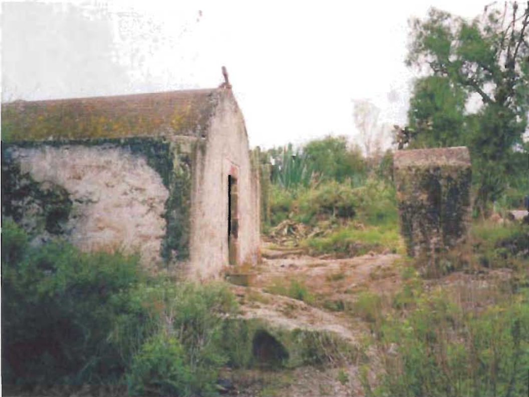
Fig. 34. Conjunto devocional orientado este-oeste. Con cruz sobre el extradós de la bóveda, un óculo en el muro norte y gárgola, todo de cantera rosa. José María Pino Suárez. Foto EMZS.
