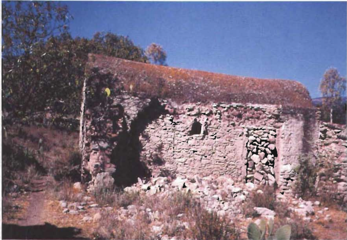
Fig. 39. Bóveda de cañón corrido en un oratorio doméstico. Tlaunilolpan, Hidalgo. Foto: RPM.
