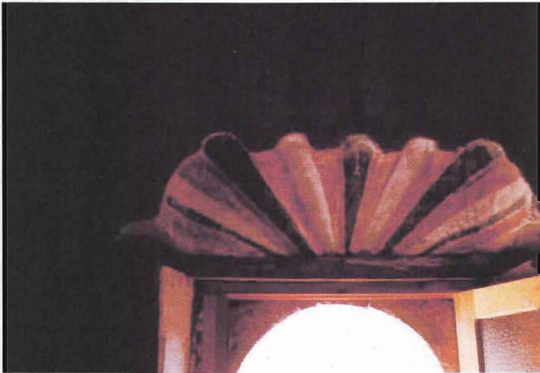
Fig. 76. Capialzado en un vano de un oratorio doméstico. San Pablo Tolimán, Querétaro. Foto: Ing. Carlos Maigler, 1998.
