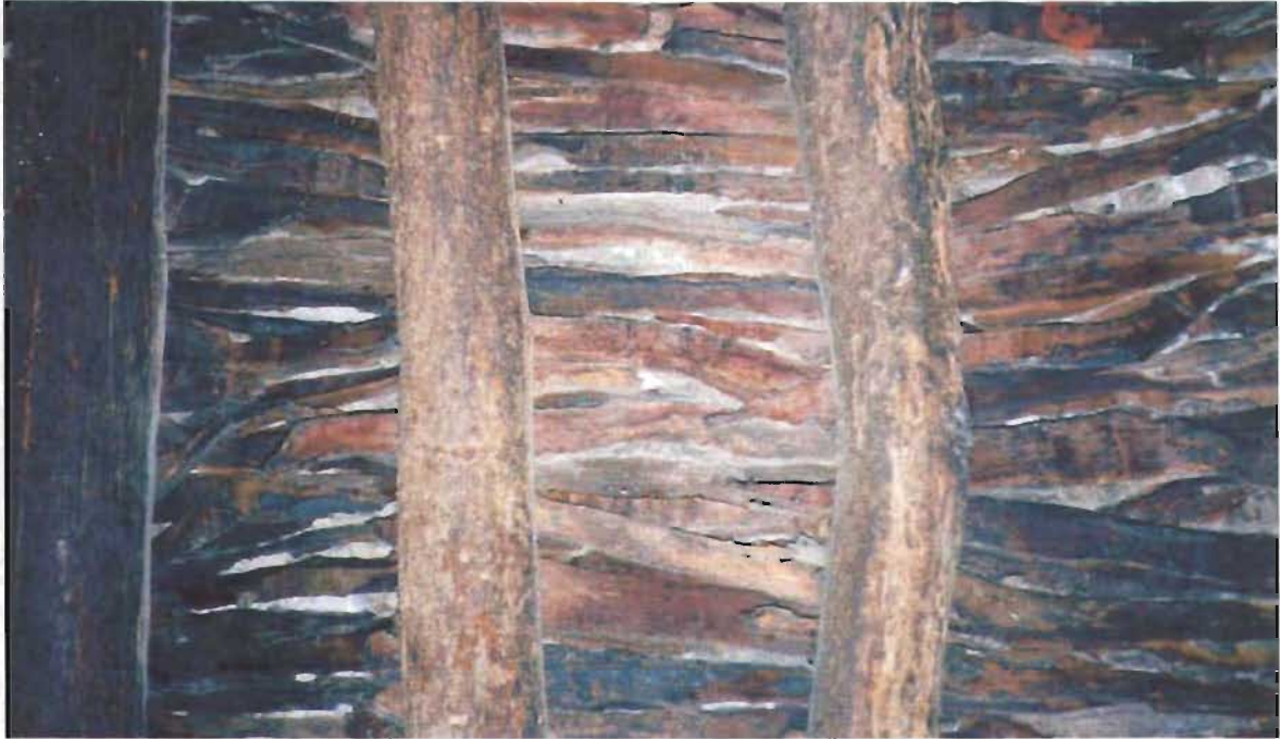
Fig. 38. Detalle de la cubierta de terrado de un oratorio. S. XIX. José María Pino Suárez, Hgo. Foto: EMZS.
