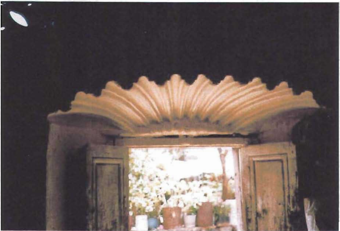
Fig. 71. Capialzado en el interior del acceso de un oratorio doméstico. Nopala, Hidalgo. Foto: RPM.
