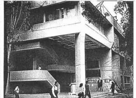
EDIFICIO DE SERVICIOS ESCOLARES ENEP ARAGON
