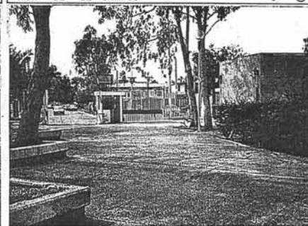
VISTA DE EL ACCESO SECUNDARIO DESDE EL INTERIOR DE EL CAMPUS
