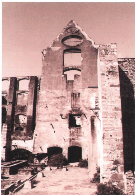
68. Entrada al cuarto de calderas E.H.S.A.C.
