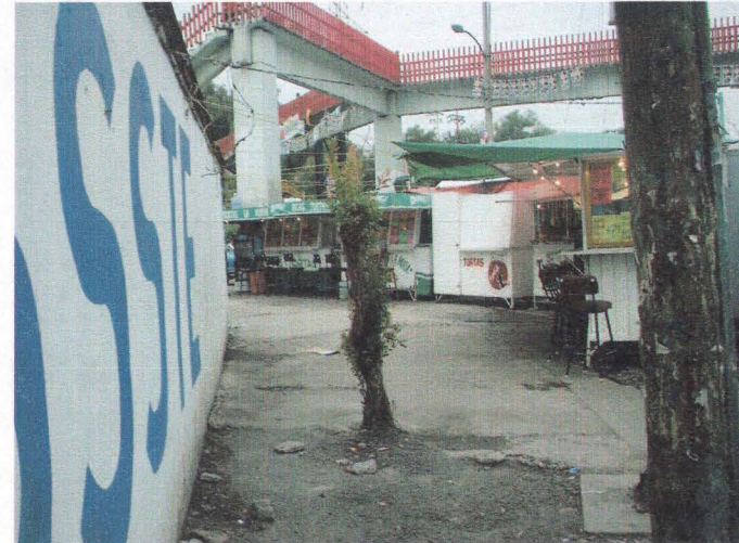
Foto 6 Puente Peatonal en deterioro de la Imagen Urbana
