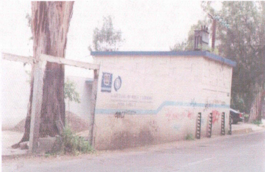
Planta de Bombeo del antiguo Acueducto
