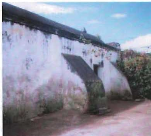
Fotografía No 6.17 Contrafuertes al interior de la fábrica. Se puede apreciar la puerta abierta posteriormente
