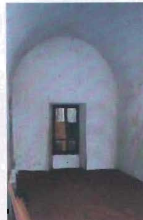
Fotografía No 6.18 Vista del interior actual de la Casamata. Ventana abierta posteriormente
