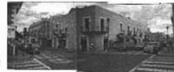
Contra esquina del terreno. Particularmente, me parece un edificio interesante, con su balcón, y sus proporciones y su dureza de trazo.
