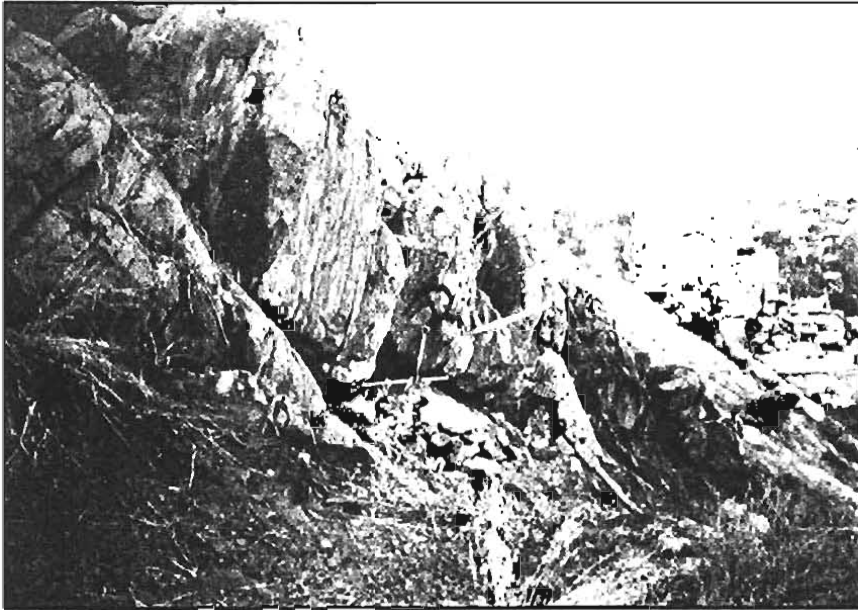
FIGURA 5.12 UN DESLIZAMIENTO FUERA DEL ÁREA URBANA PODRÍA LLEGAR AFECTAR A LAS VIVIENDAS
