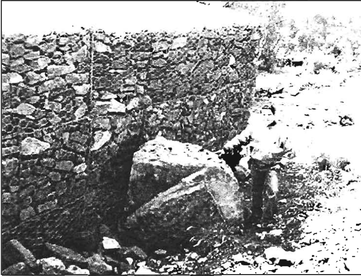
FIGURA 4.17 MURO DE GAVIÓN COMO ESTRUCTURA DE RETENCIÓN
