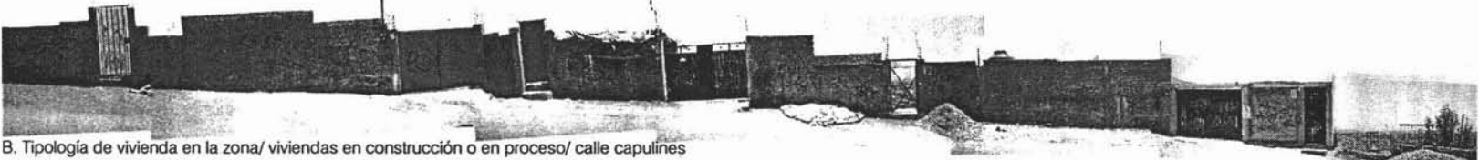
B. Tipología de vivienda en la zona/ viviendas en construcción o en proceso/ calle capulines
