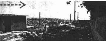
D. Vista del estado actual de la avenida
