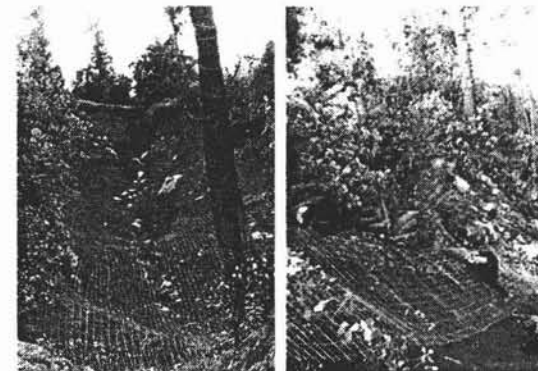
88. Foto de la condición predominante en la zona es la alta Pendiente, que van desde 10% hasta el 40%
