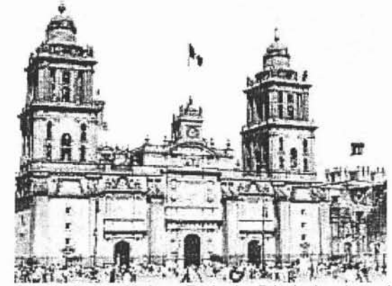
Catedral de México. Fachada Principal sobre el Zócalo, plaza principal de la Ciudad.
