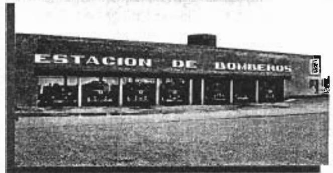
FACHADA PRINCIPAL, SALIDA DE CAMIONES
