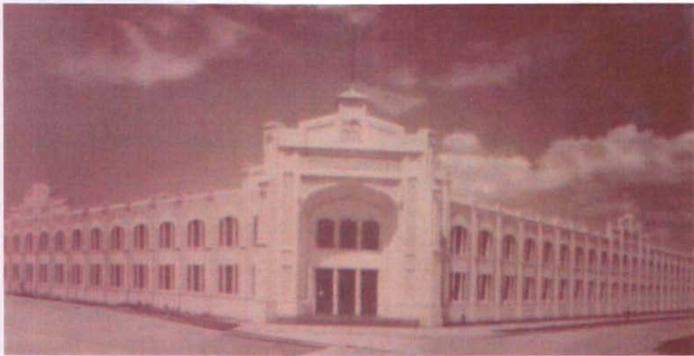
Fig. 9.- Fachada de la Escuela Industrial y Preparatoria Técnica Álvaro Obregón . Foto tomada de Reseña Histórica del 50 Aniversario . Fechada el día 30 de octubre de 1930.
