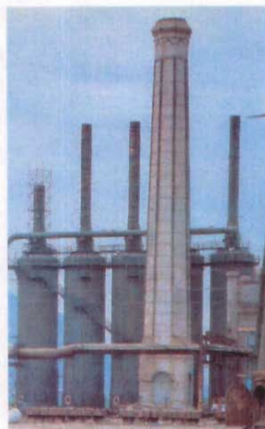
Fig. 18.- Horno alto n° 1 Fundidora Monterrey S. A. Tomada de Fundidora: Con raíces de acero , Blanca Belden Larralde. Editora. 1991.
