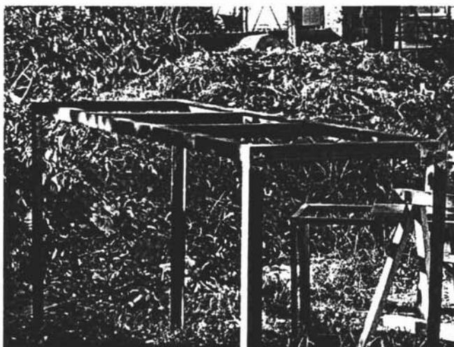
Figura 4.18. Estructura de soporte lateral y refuerzo superior
