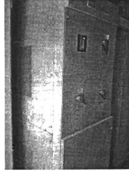
6.19. Tableros con interruptores sin identificar.
