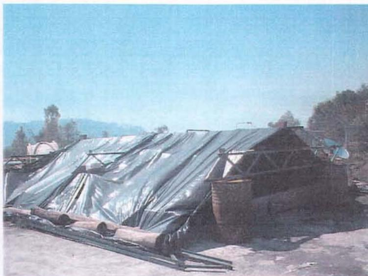
Protección de las inclemencias del tiempo con armazón metálico y cubierta de plástico
