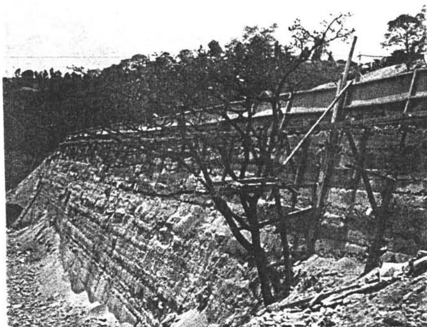
Fig. 5.4.9. Vista lateral del muro de Suelo-Cemento.
