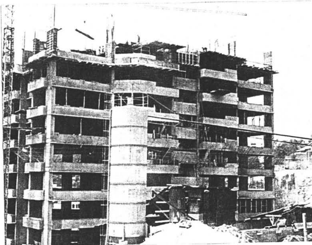
Fig. 6.2.2.1. Vista de Torre Esmeralda en construcción.
