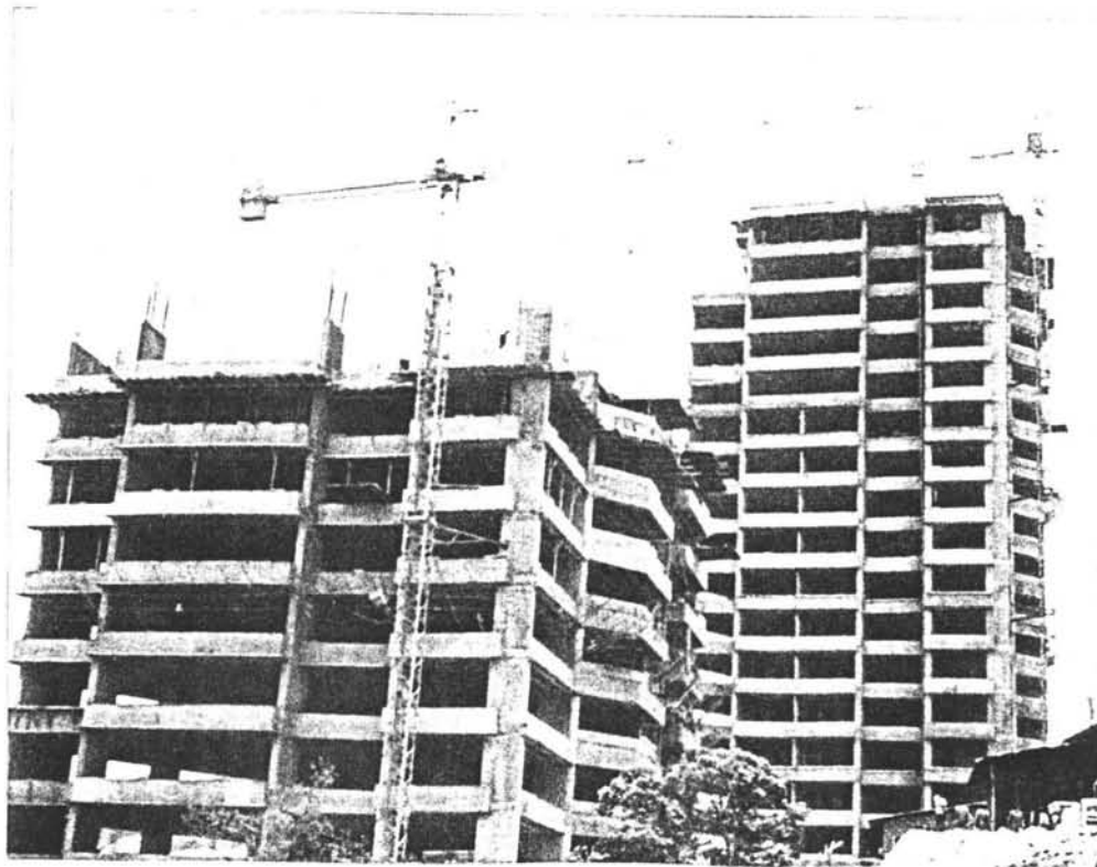
Fig. 6.2.2.4. Torre Zafiro al 50% de avance.
