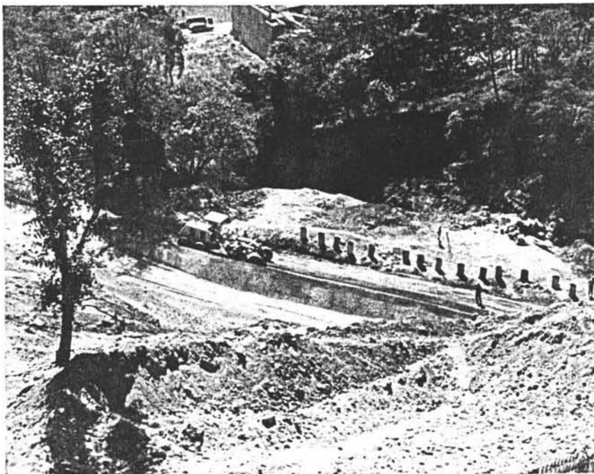
Fig. 5.3.2. Proceso de extender el material de Suelo-Cemento con la Motoconformadora.
