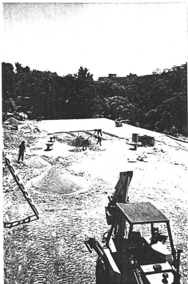
Fig. I.1.2. Suelo-Cemento en la construcción de la cancha de tenis como mejor opción.
