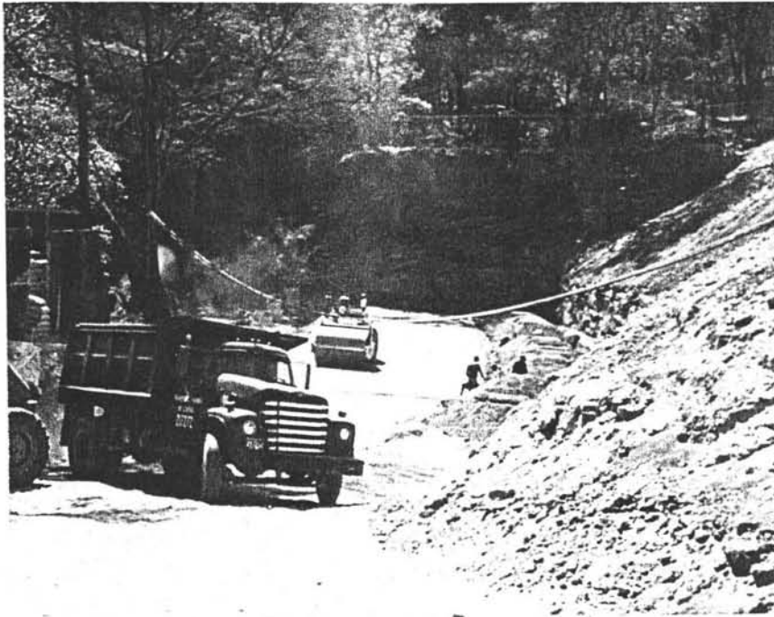
Fig. 5.3.3. Compactar el Suelo-Cemento con el Rodillo Vibratorio.
