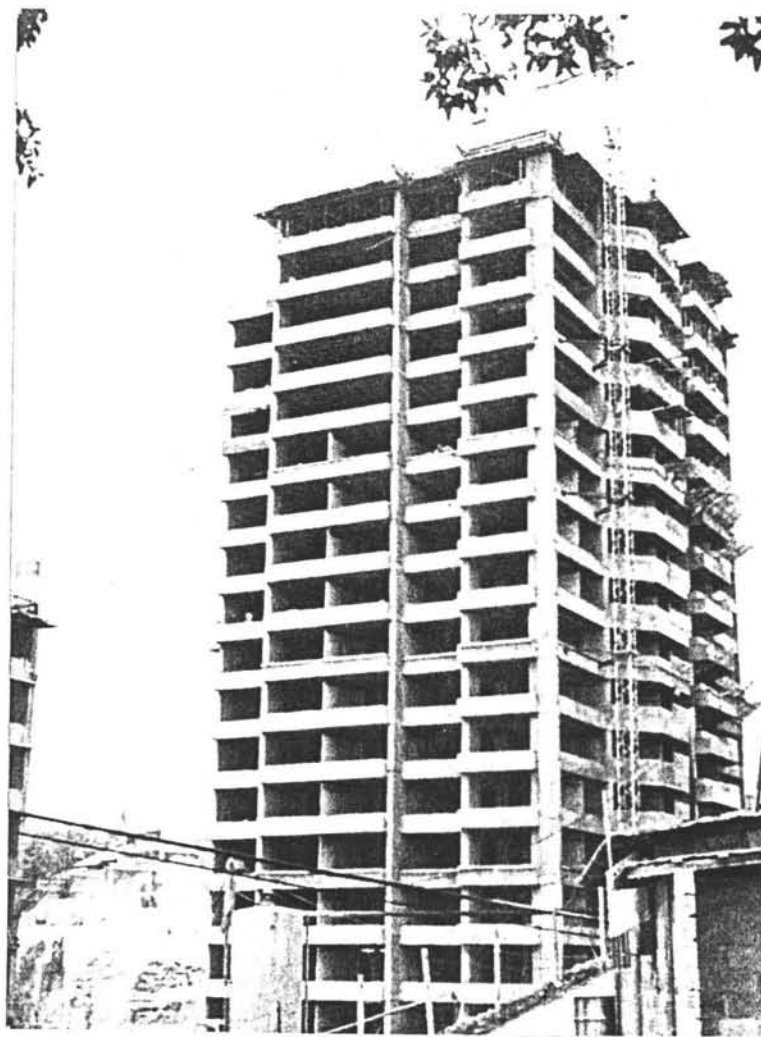
Fig. 6.2.2.3. Torre Esmeralda al 100% de avance.
