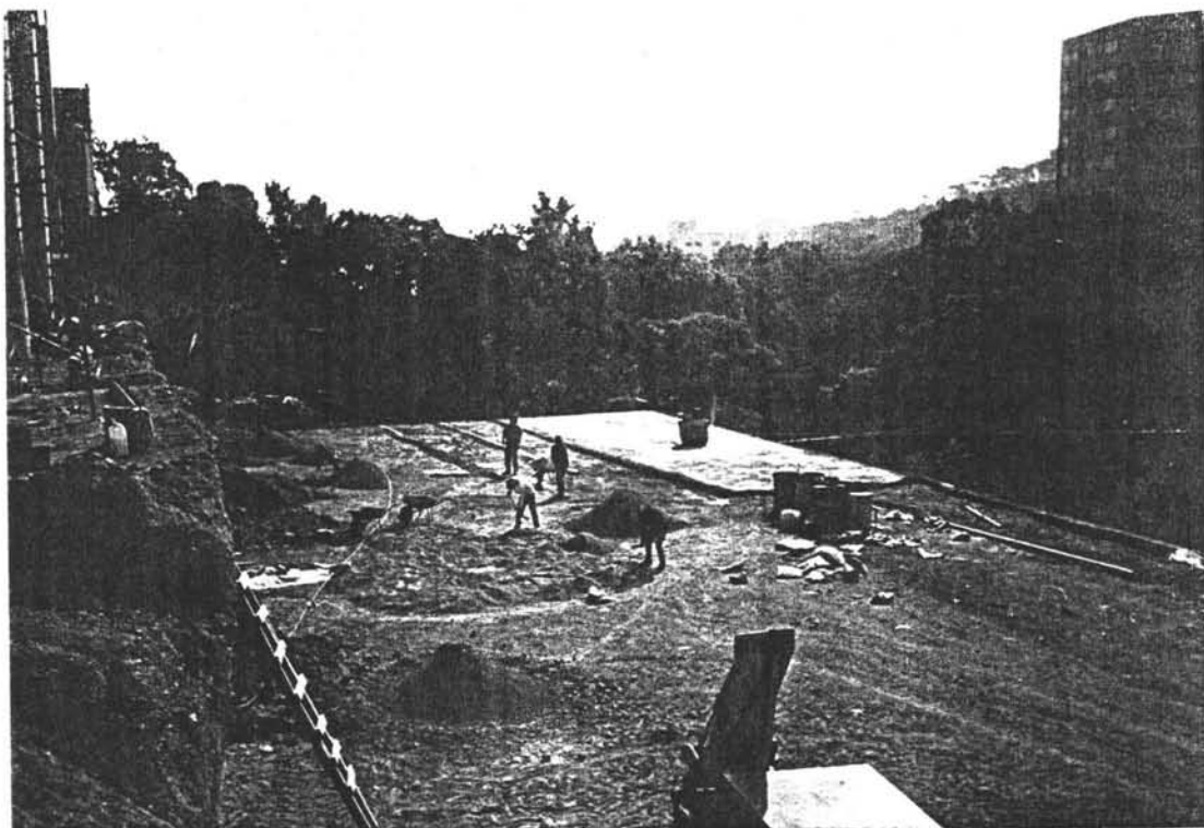
Fig. I.1.1. La construcción de la cancha de tenis.
