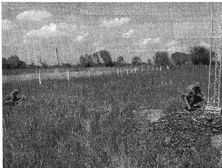
Figura.5.14. Nivelación de retenida a nivel de terraplén.
