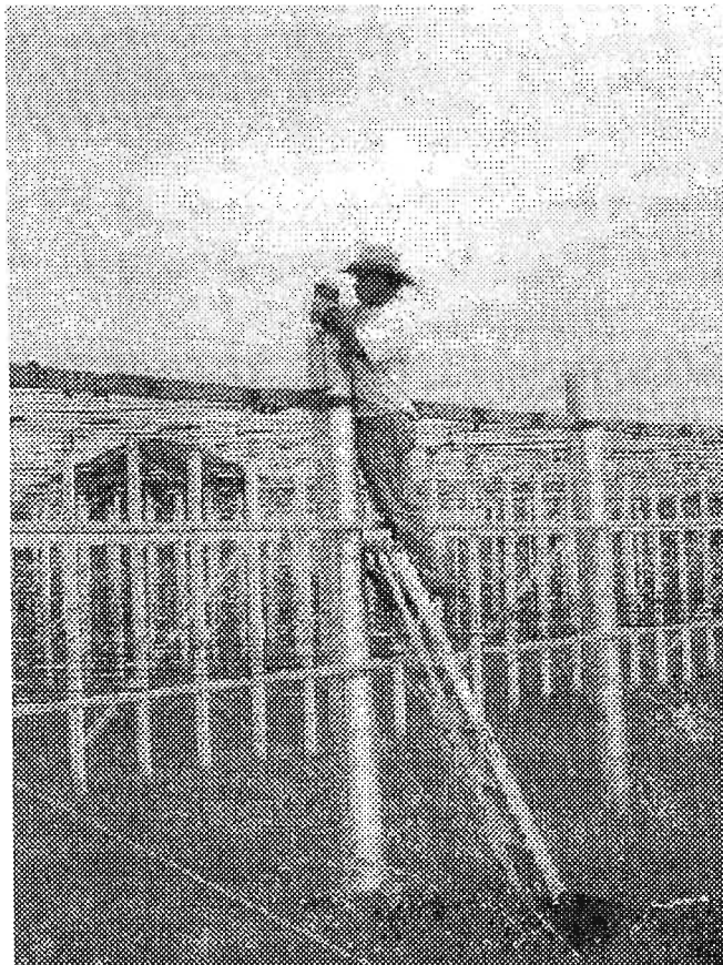
Figura.5.24. Colocación de base de para rayos en la base de concreto
