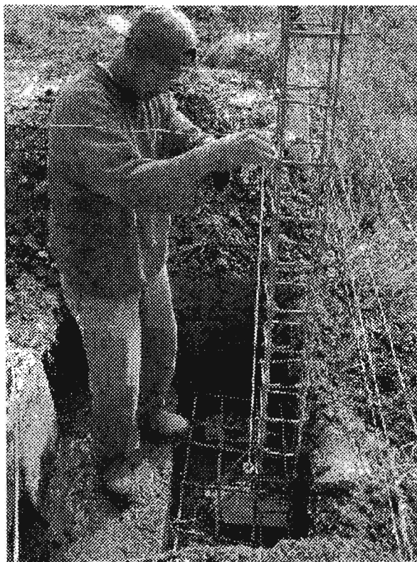
Figura. 5.16. Armado de castillo.
