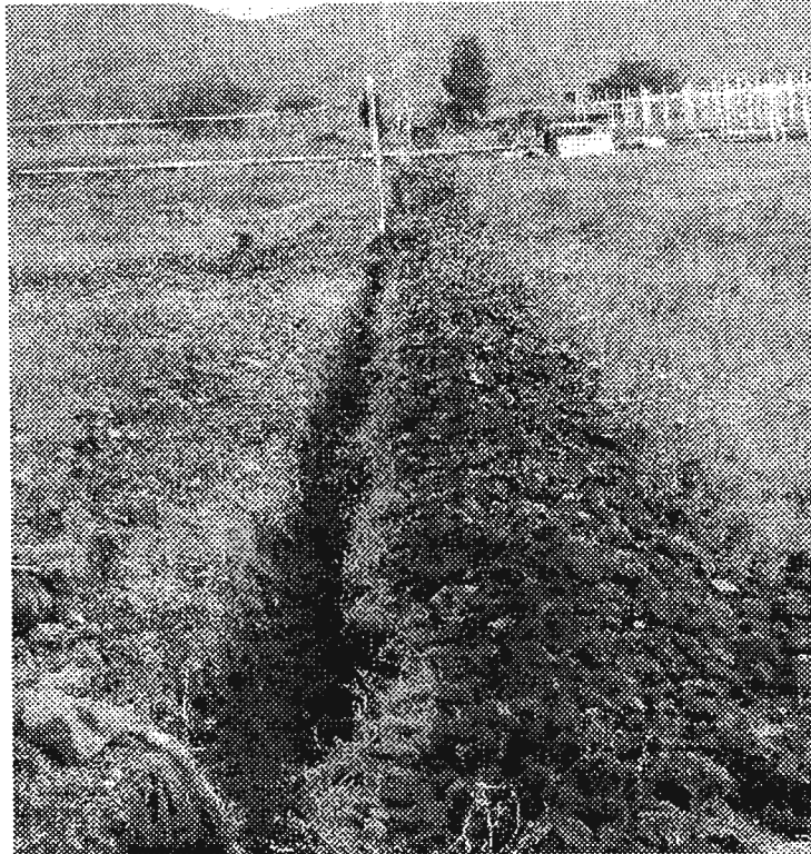
Figura 5.9. Excavación perimetral correspondiente al anillo perimetral.
