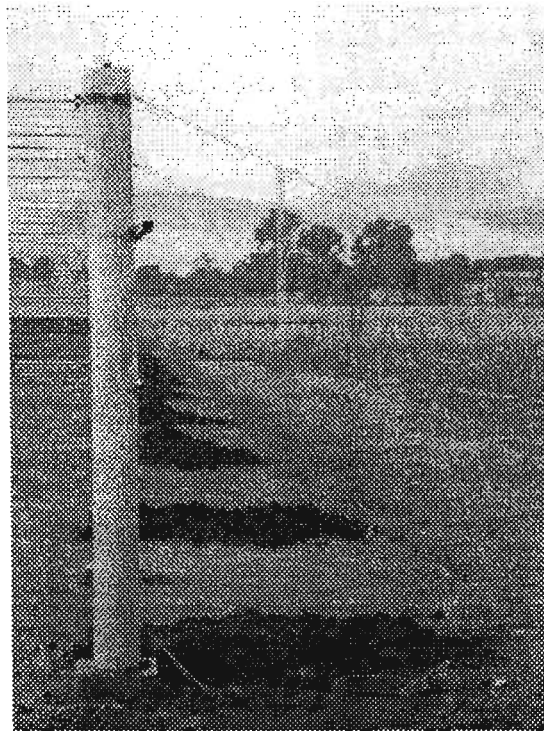
Figura 5.8. Base tubulares lado oeste.
