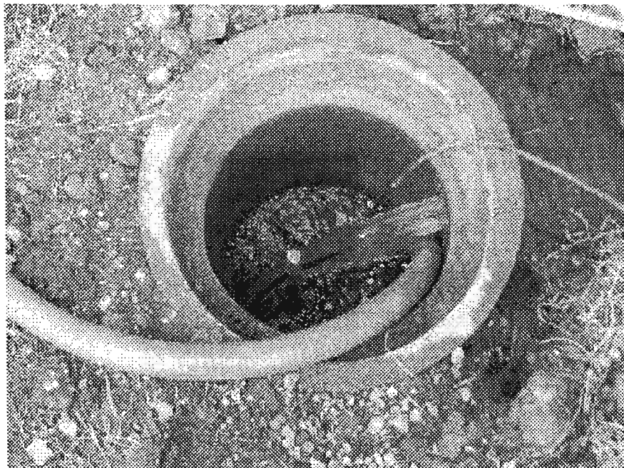
Figura.5.29. Bombeo de agua.
