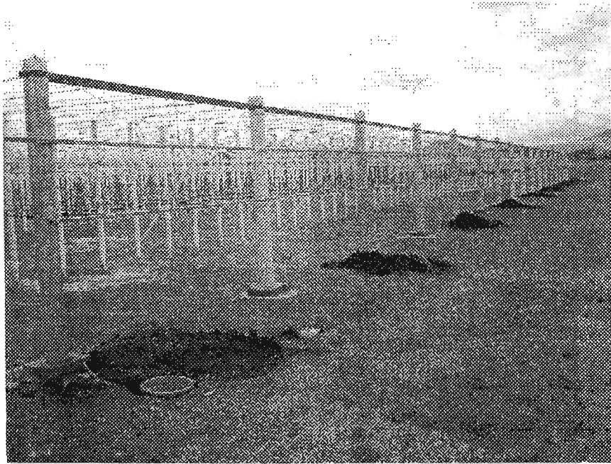
Figura 5.7. Bases tubulares lado este.
