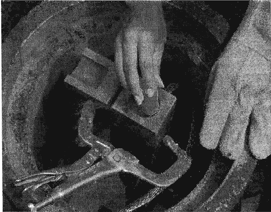
Figura.5.30.Colocación de soldadura exotérmica.
