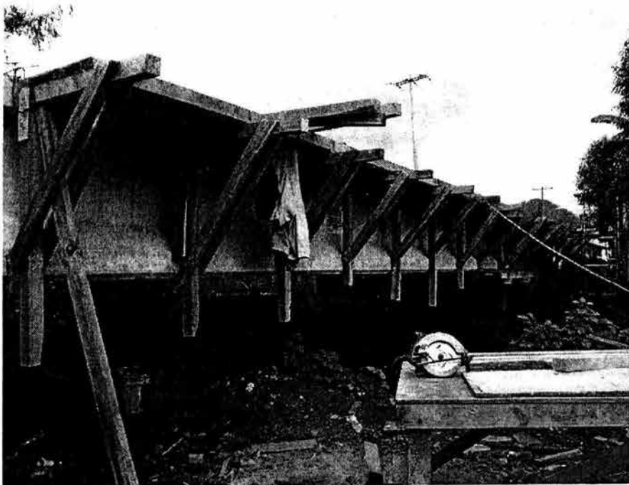
Fig. 7.2 Detalle Cimbra Lateral
