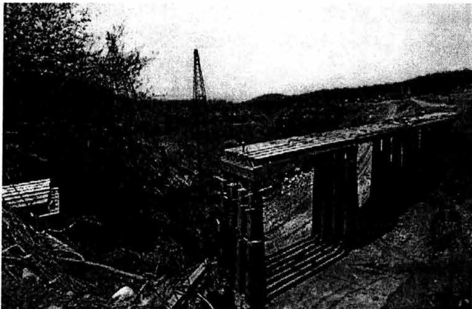
Fig. 6.19 Montaje de Traveses
