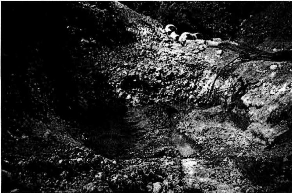
Fig. 4.9 Excavación Azolvada y Bombeo de achique
