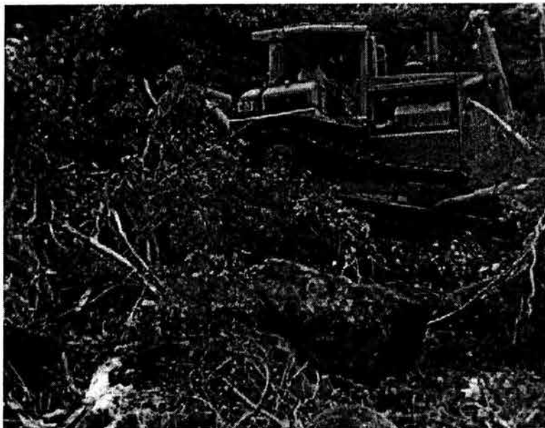
Fig. 4.5 Tractor D8 Realizando Despalme
