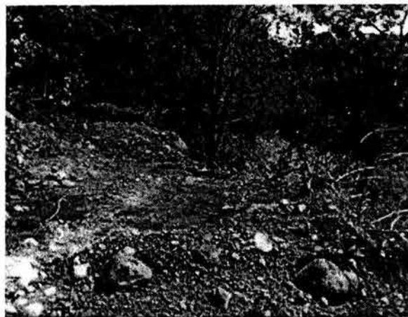
Fig. 4.2 Camino de acceso a la cimentación Puente Barranca El Limón
