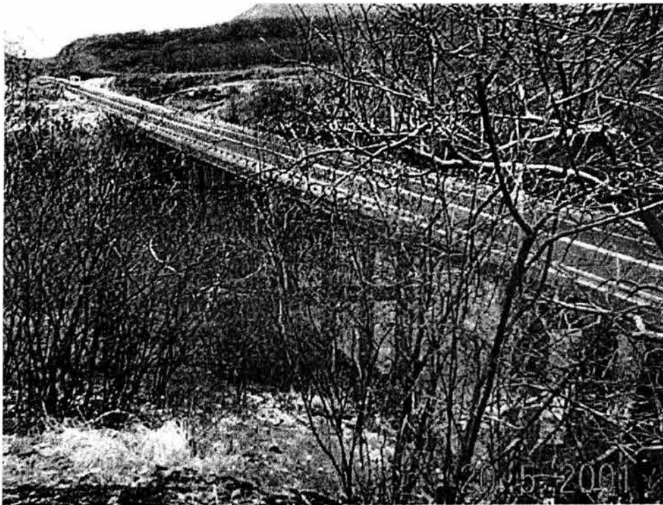
Fig. 8.1 vista de Puente con guarniciones y Señalizado
