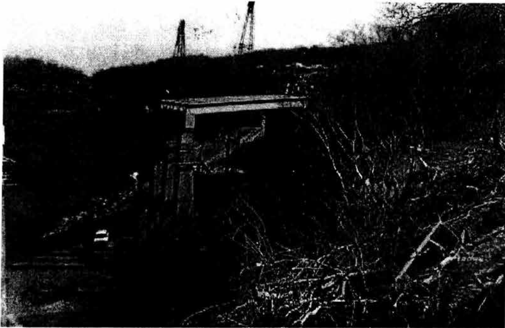
Fig. 6.16 Montaje de Trabes
