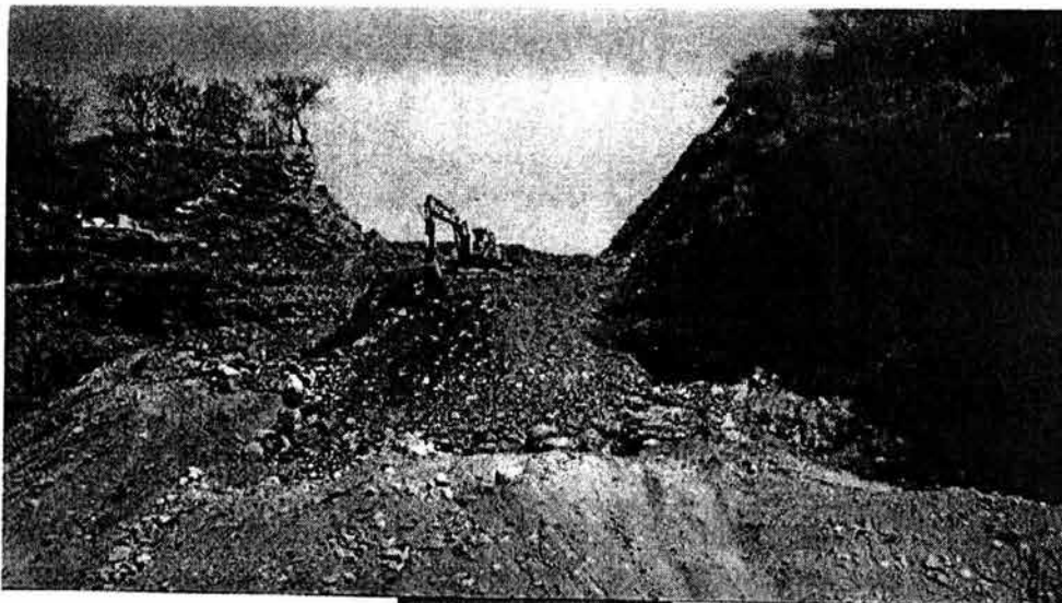
Fig. 4.13 Excavación en Estribo #1
