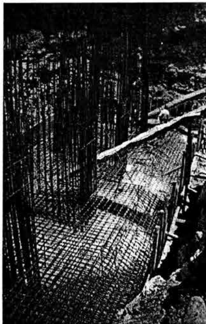
Fig. 4.15 Acero y cimbra en Zapata, Canales Colocados para Colado
