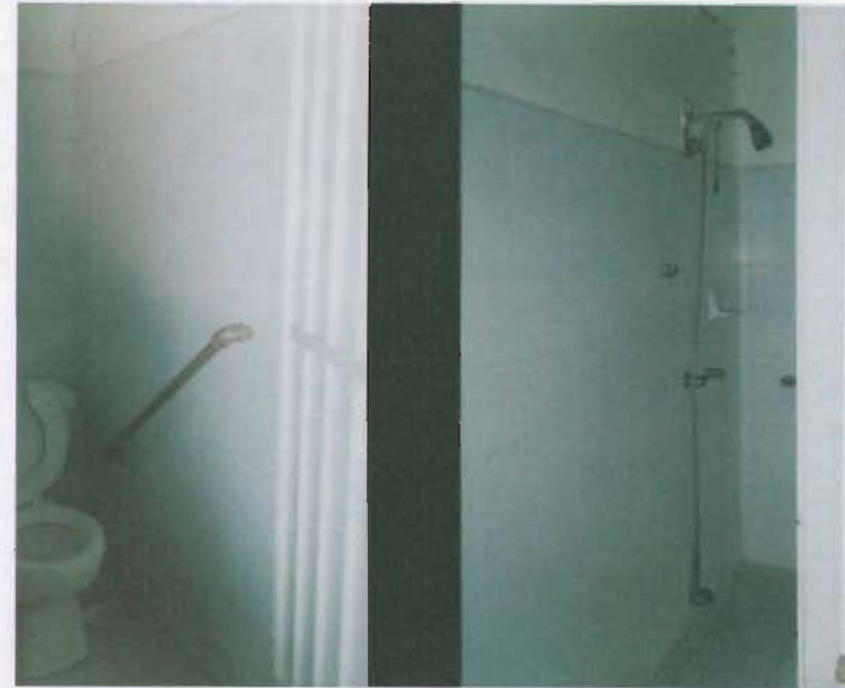
Baños con barras para tercera edad.
