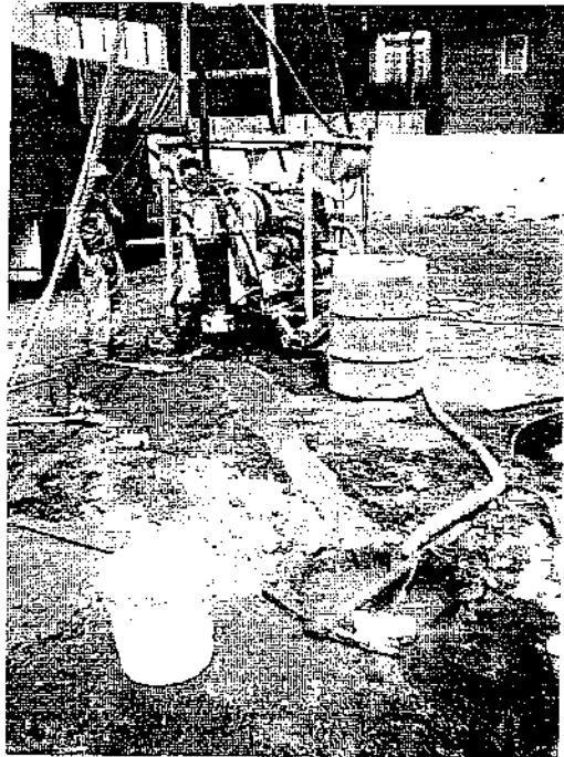
IZQ. SE OBSERVA INICIO DE PERFORACIÓN CON BROCA TRICONICA DER. CARCAMO PARA RECIRCULACIÓN DEL LODO BENTONITICO
