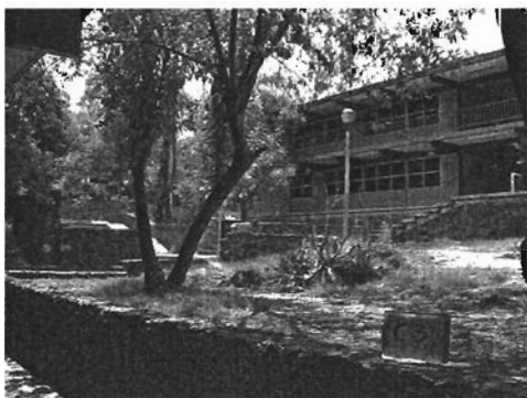
ESTACIÓN 16 ÁREA C 3
