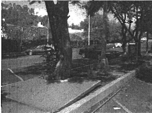
Efectos de mala plantación en el estacionamiento
