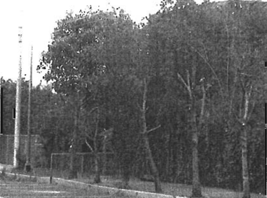
Fresnos ( fraxinus ) creciendo bajo líneas eléctricas del CCH Sur en el estacionamiento de profesores
