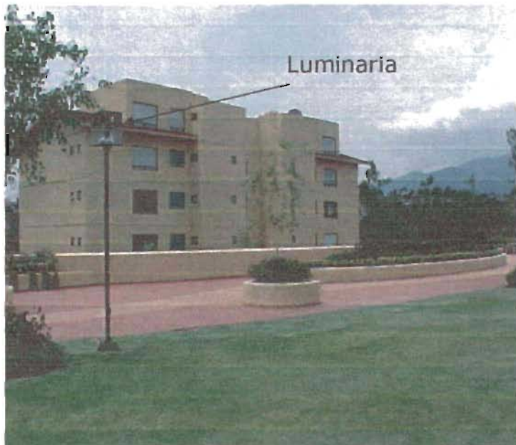
Fotografía 19. Luminaria Bekolite CUBIL-A.
