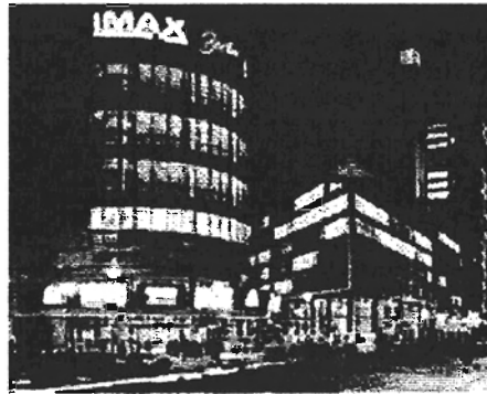
Esquina del acceso al Imax al fondo se observa uno de los rascacielos que limitan el conjunto
