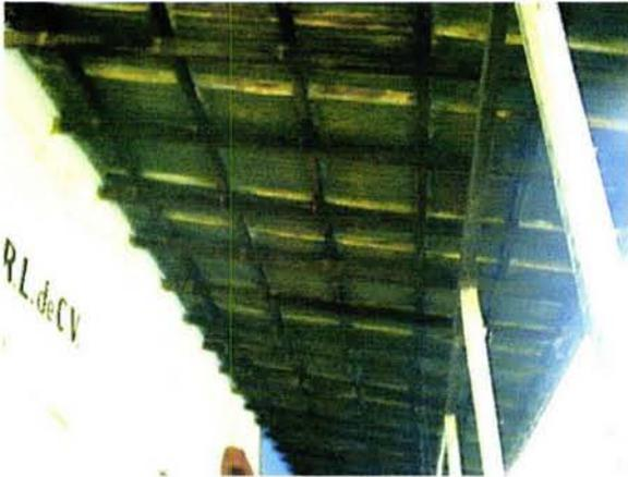
*Imagen 59. Estructura de cubierta, vigas secundarias*
