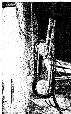
**Figura 4.-** Fotografías que muestran la maquinaria utilizada en la perforación para los micropilotes, en diferentes posiciones al interior de diferentes inmuebles.
