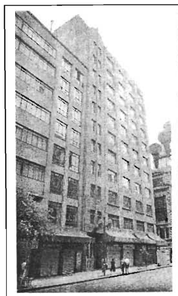
Edificio Fundación Mier y Pesado, J: Segura 1931
