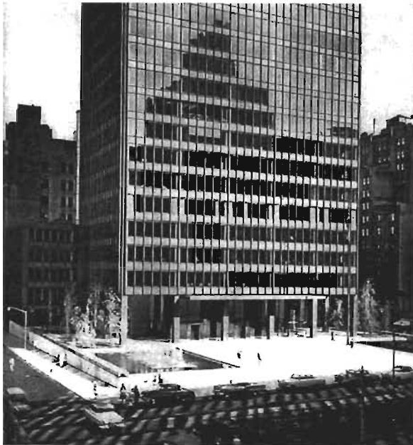
114. Mies van der Rohe, Edificio Seagram, Nueva York, 1958. Vista de la planta baja de acceso. (Drexler 1960: 95)
