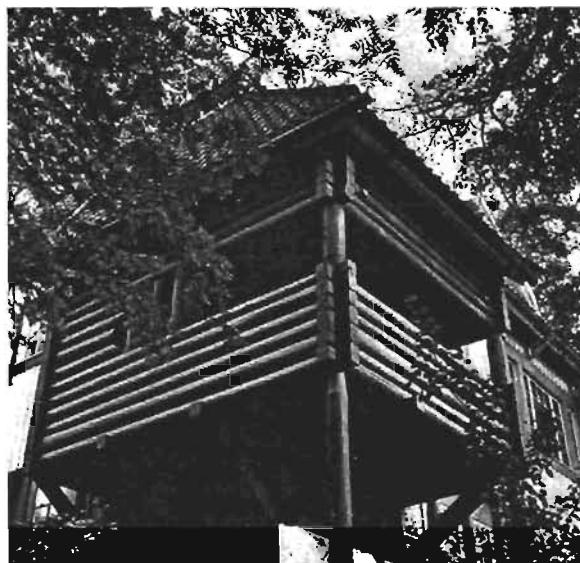
88. Lars Sonck, casa Ainola, Finlandia, 1902. Vista en detalle de habitación construida en sistema tradicional. (Quantrill 1983: 10)
