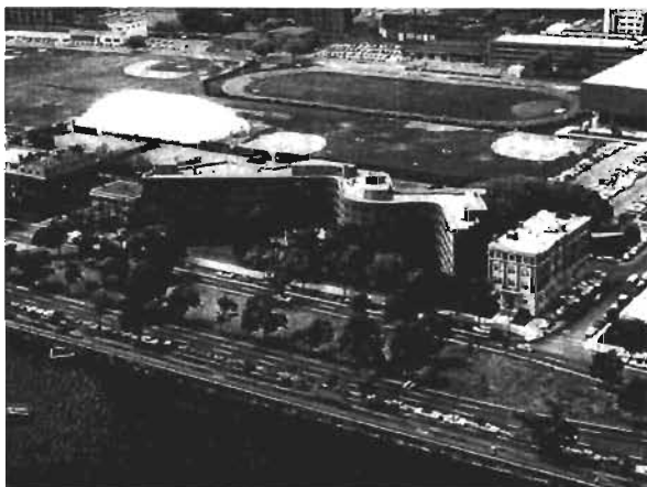
168. Dormitorios de Estudiantes del MIT, Boston, 1947-49. Vista aérea enseñando la implantación sinuosa del edificio en relación a las vías de tráfico y río. (Baker 1996: 296)
