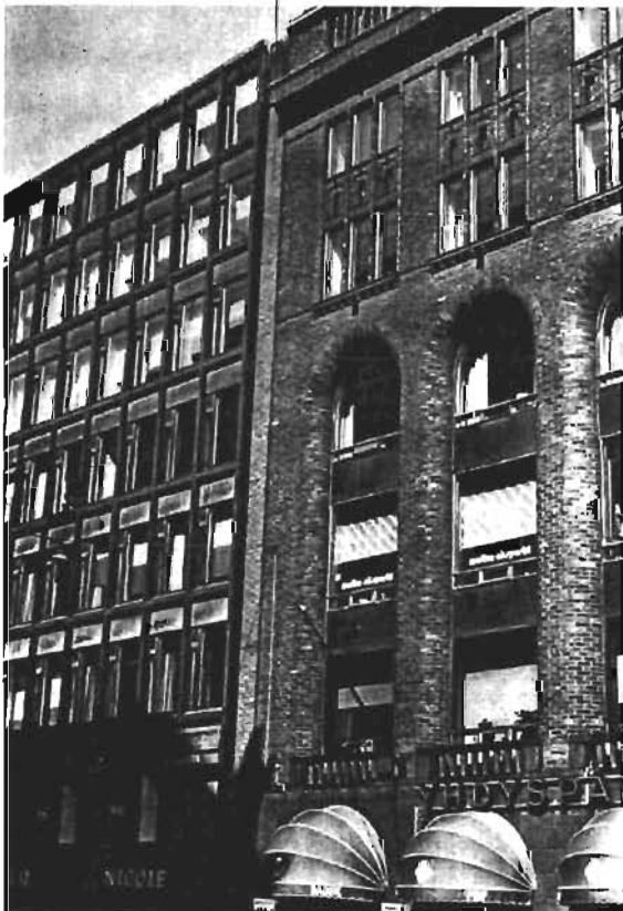
161. Edificio de oficinas Rautatalo, Helsinki, 1952-55. Perspectiva desde la calle enseñando los dos edificios vecinos (Schildt 1994: 138). Vista desde la calle hacia la conexión con el edificio colindante de igual altura (Quantrill 1983: 160).
