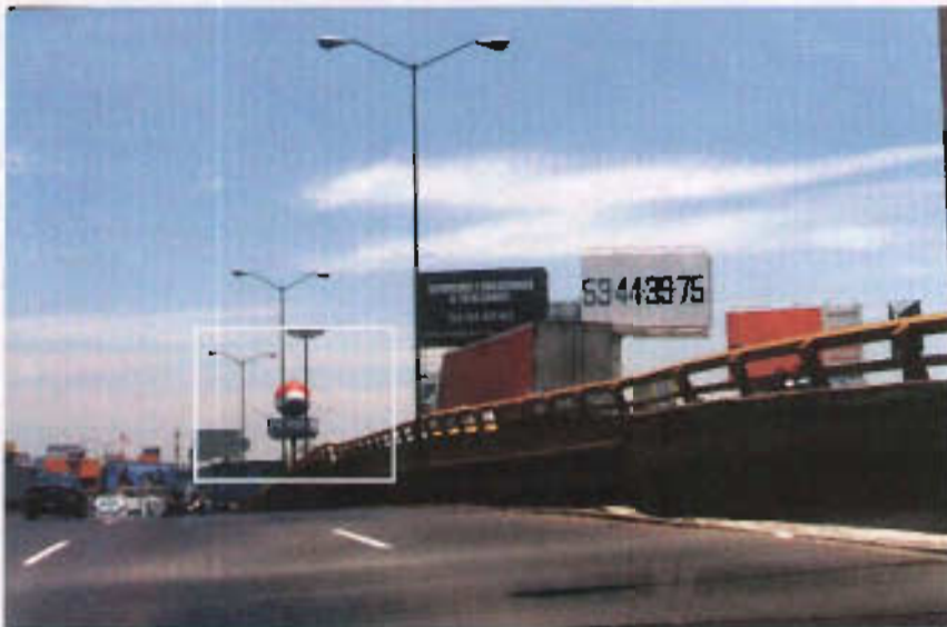
Perifoneo y Viaducto México D.F. 2000 Vista Sur
