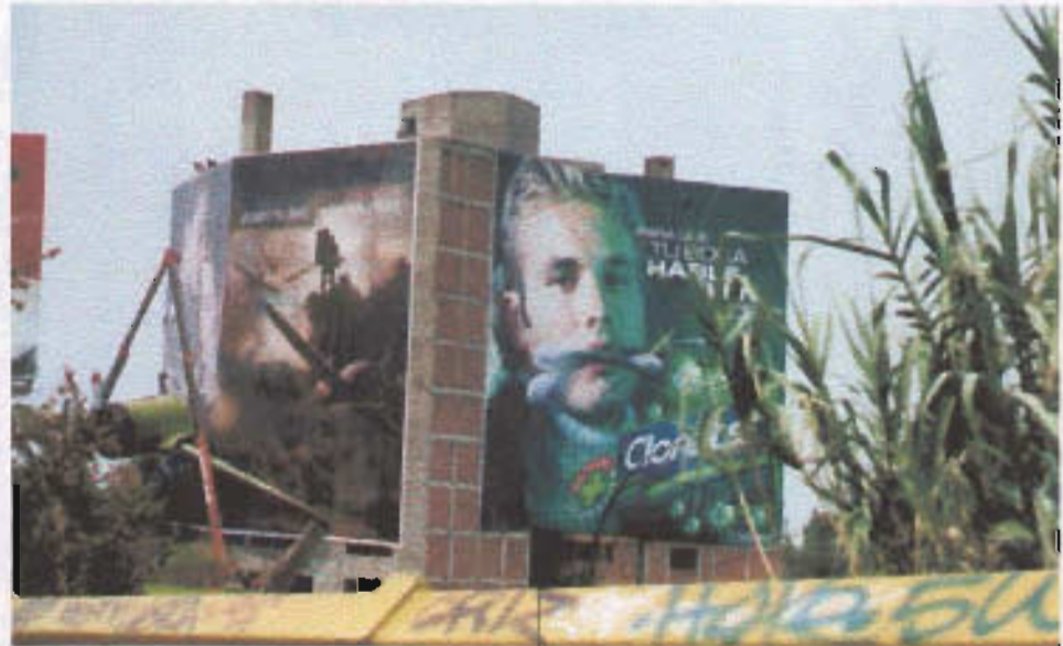
■ Periférico (frente a Comisión de derechos Humanos) puente Luis Cabrera México D. F. Muro Vista Sur
