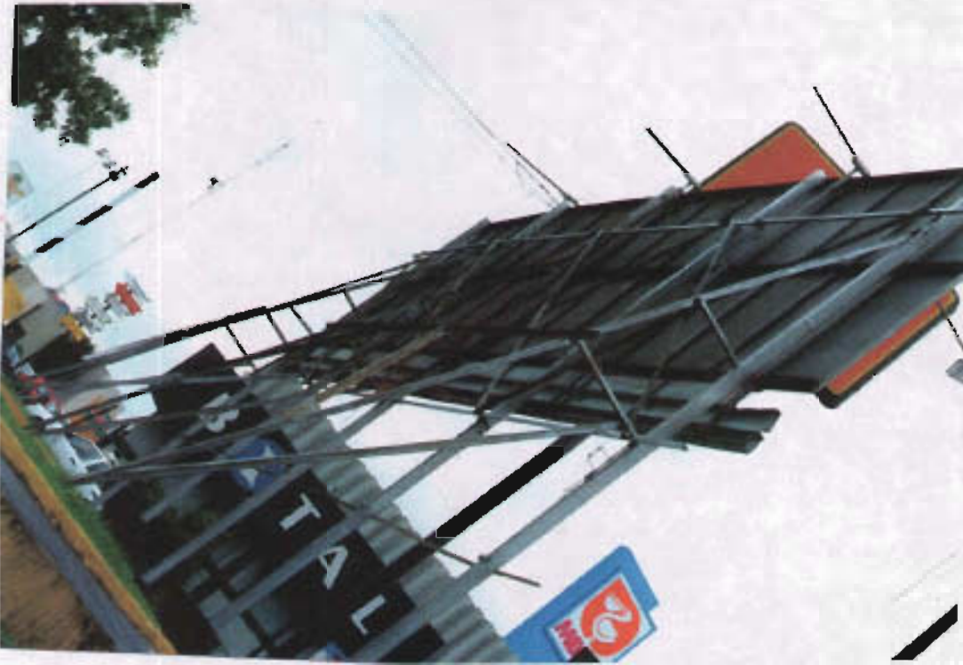
■ Periférico Sur y San Jerónimo México D. F. 1998 Cartelera: anuncio tipo denominativo Área visual 3.60 x 12.90m Con 4 m de patas de vigas
