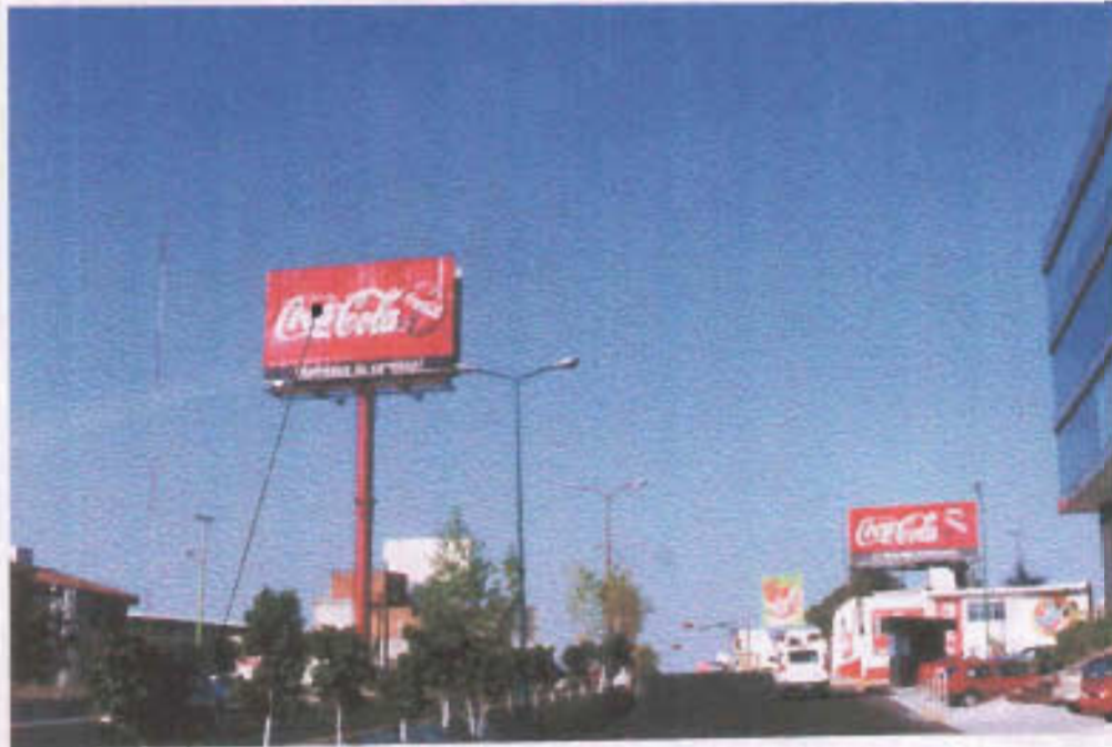
■ Periférico Sur esquina Av. Tohaca Puebla 1998 Unipolar 12.90 x 7.20m Vista Sur
