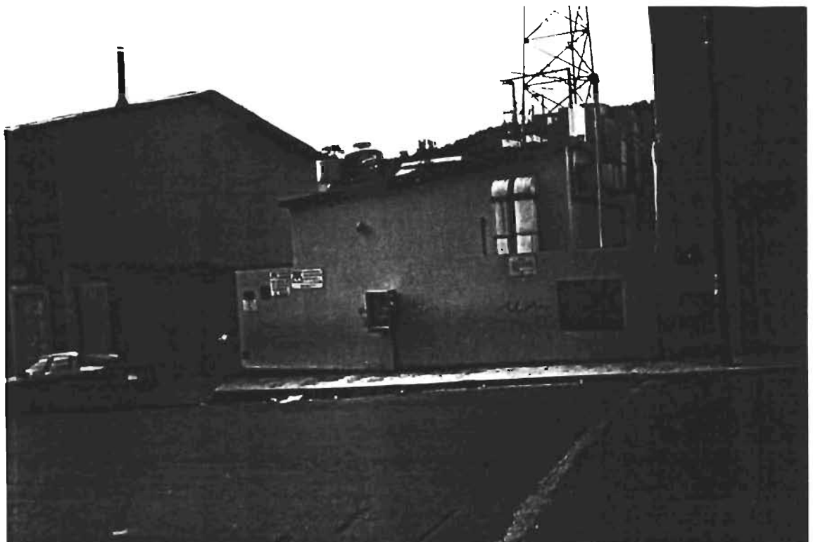
Foto 4.19 Central telefónica de TELMEX en el pueblo de Mineral de Angangueo
