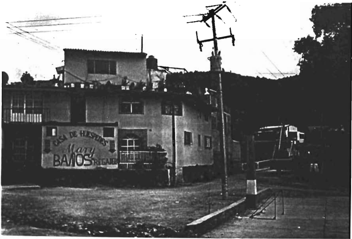
Fotografía. 4.16 Casa de huéspedes Mary.
