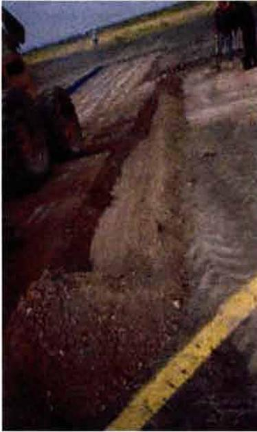
Foto 6.7 Retiro y desperdicio de la base arcillosa
