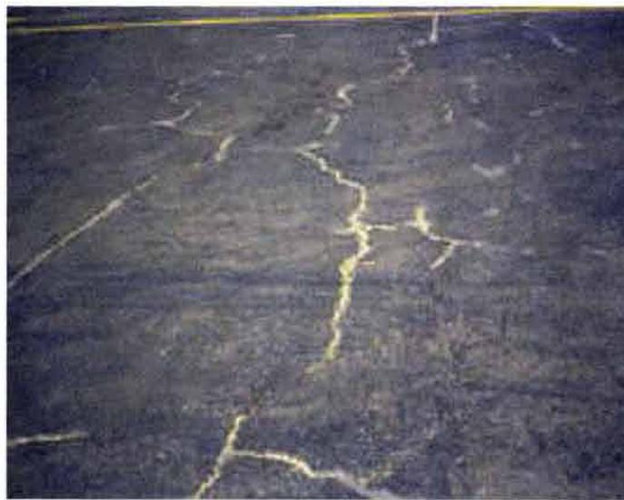
Foto 6.9 Las grietas de reflexión se interrumpieron al sustituir el pavimento arcilloso con la Sección Invertida de grava triturada sin finos
