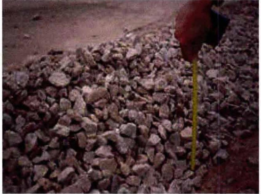
Foto 6.8 Base totalmente triturada de 3" de tamaño máximo (BGT), apoyada en subbase rigidizada con cemento Portland (SBR)
