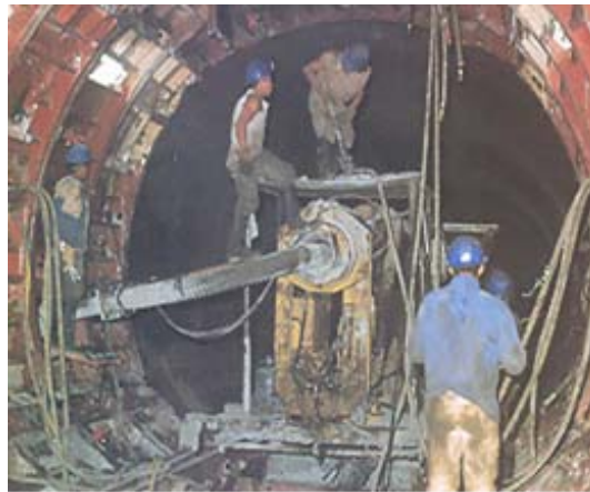
Figura 2.1 Trabajos en el túnel.
