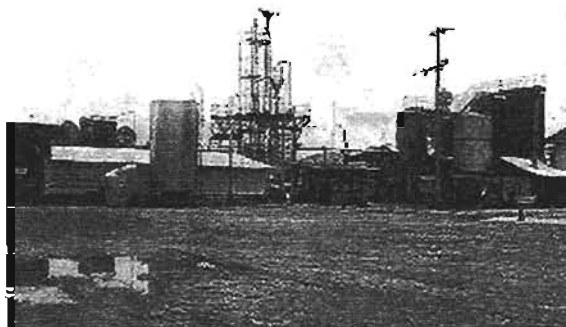
Figura 2-9: Planta destiladora de resinas (86)
