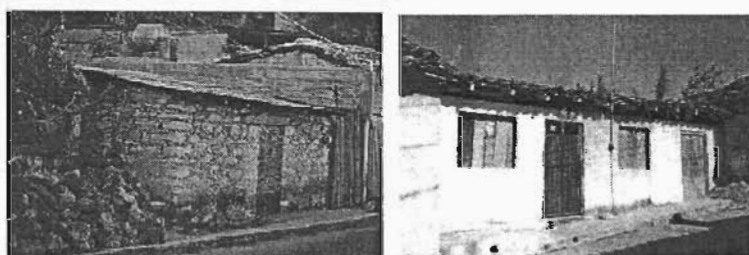
Figura 3.8 Mampostería sin refuerzo
