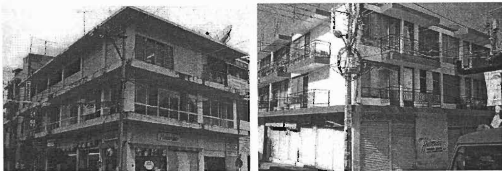
Figura 3.13 Estructuras de concreto con sistemas de piso prefabricado.
