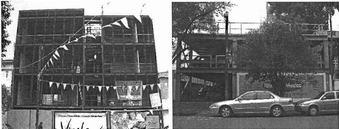
Figura D.21 Estructura a base de marcos de concreto.
