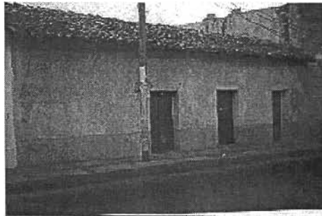
Figura D.9 Mampostería de Adobe.
