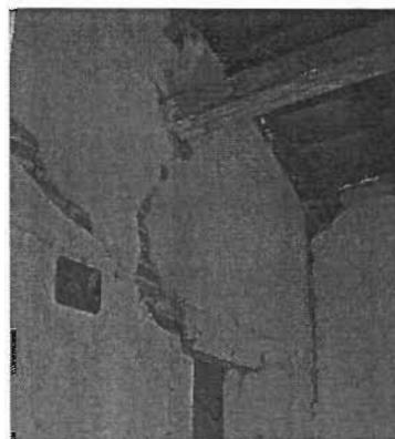
Figura D.5 Penetración de las viga en el muro
