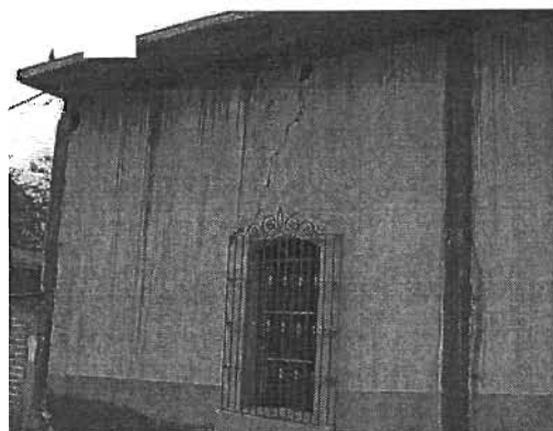
Figura D.12 Adobe con sistema de piso de concreto.
