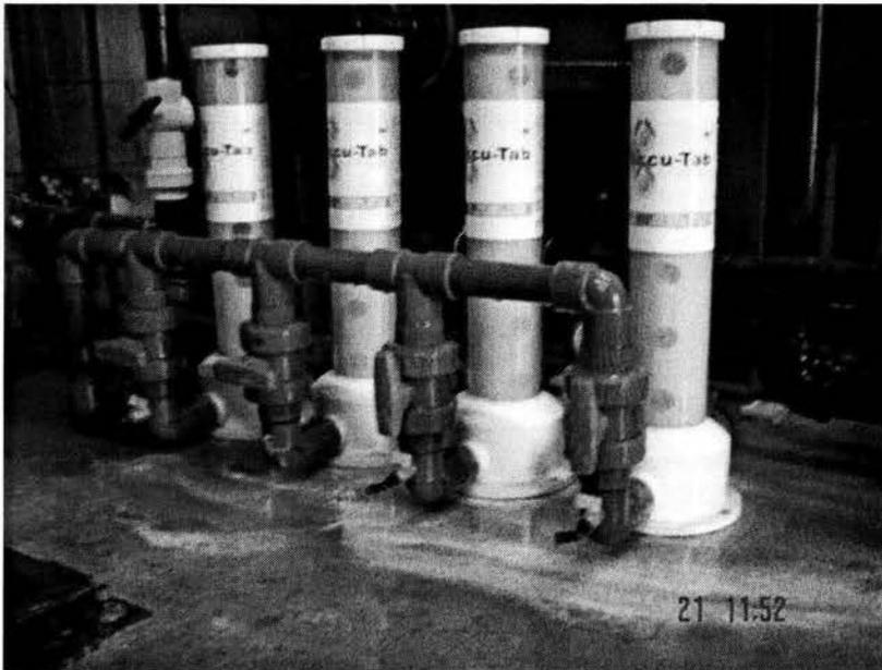
Figura # 19 Sistema de dosificación de cloro con tabletas
