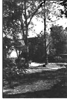
Foto 9 Vista hacia el acceso del Despacho-Estudio donde se percibe el juego volumétrico característico de la arquitectura de Attolini Lack, detrás del elemento vegetal.
