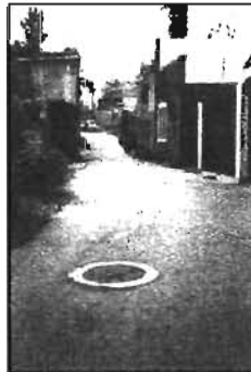
Foto 5 Vista desde el acceso del Despacho-Estudio hacia la calle secundaria. Edificación sin valor arquitectónico.
