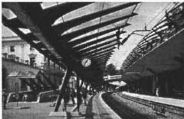
Arriba: La Estación de Trenes de Stadelhofen, la gran galería de ambulatorio entre la zona de andenes y el edificio de la estación; y el sistema de metálico de cubierta de los andenes.
