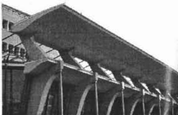
Abajo: La Estación Central Lucerne, con su sistema de pórticos de fachada y contrapesos estructurales.
