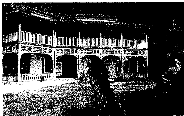
El Museo Municipal de Varadero es una excelente muestra del primer estilo constructivo del lugar: casas de madera de dos pisos y ventanas arboladas.
