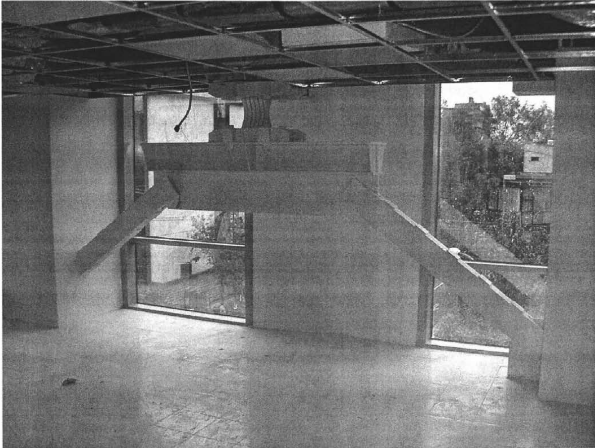
Fig. 1.1 b Amortiguador Tipo ADAS (Ref. 23)
