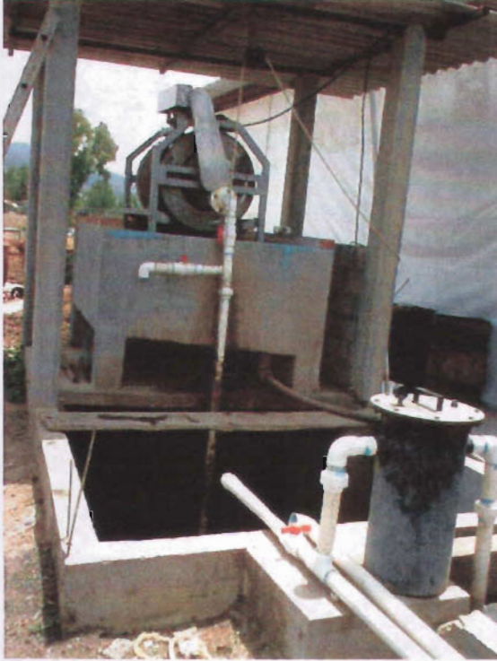
Figura 2.- Sistema de tratamiento de aguas residuales de tipo primario con separador de sólidos por medio de un dispositivo de tipo cilíndrico y con proceso de sedimentación, en una granja porcina a pequeña escala.
