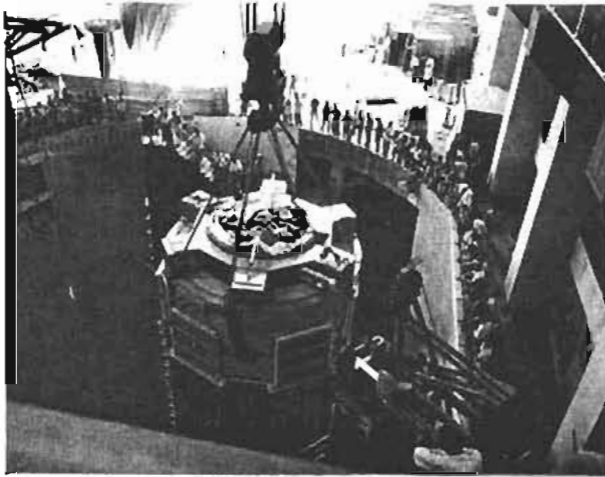
Instalación de un generador
