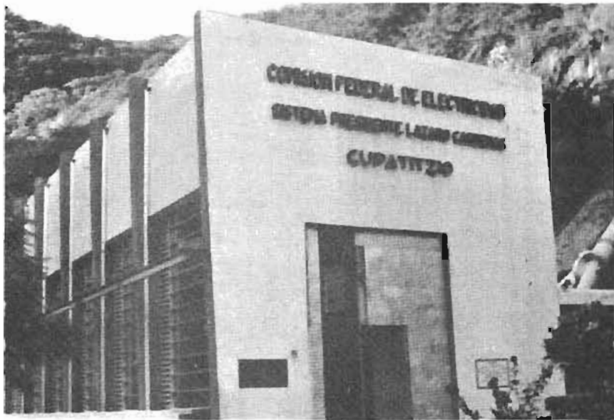
Figura 5.6. Planta de Cupatitzco (México) tiene 2 turbinas Pelton de 4 chiflones c/u con una potencia unitaria de 53,000 HP trabajando bajo una carga de 450 metros (fotografía tomada por el Ing. Pedro Alonso)
