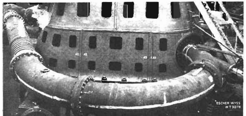
Figura 5.4. Muestra de dos de las agujas que controlan el flujo de las turbinas tipo Pelton de la planta de aberthasi (suiza).
