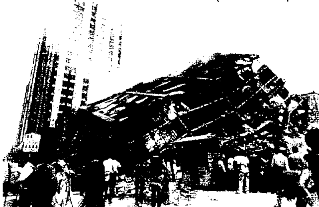
Figura 1.13 Edificio de acero del conjunto Pino Suárez ( www.cenapred.unam.mx ).
