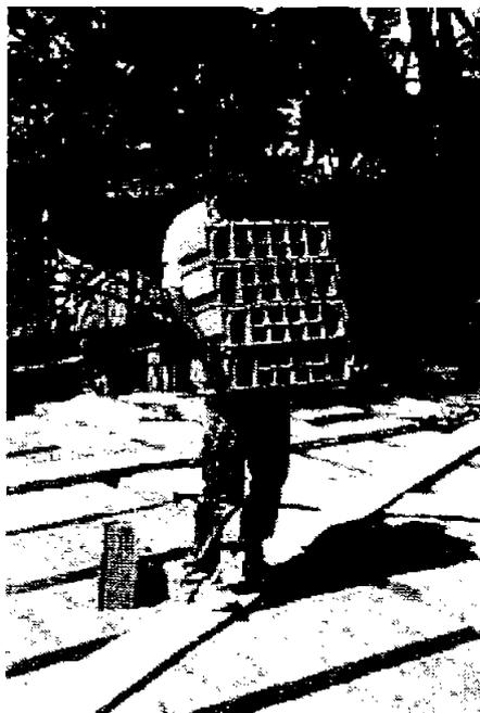
*Fig.33 Viguetas de concreto y bovedillas ligeras de barro.*
