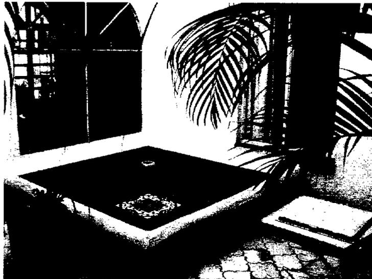
*Fig. 61 Estanque decantador con el tubo que derrama el agua hacia dentro del aljibe. Registro elevado para evitar que al barrer se ensucie el aljibe.
