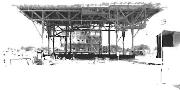
Figura 1.23 Al frente se muestra la estructura de un helipuerto que será colocado en una plataforma de perforación, en la Sonda de Campeche, al fondo se alcanza a observar la superestructura de una plataforma habitacional. México (2002).
