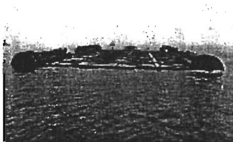
Figura 1.16 Subestructura para aguas someras después de ser lanzada y antes de colocarla en posición. (Graff W. J. 1918)
