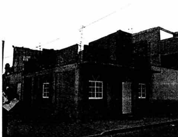
Estado actual de la vivienda
