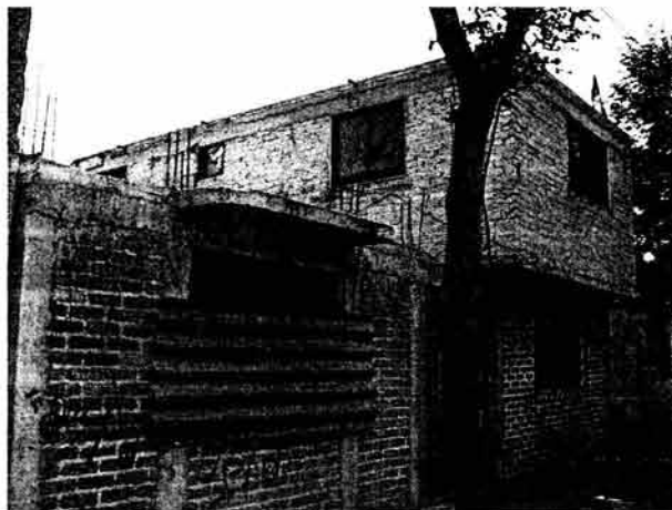
Vivienda en proceso de construcción debido a desdoblamiento familiar
