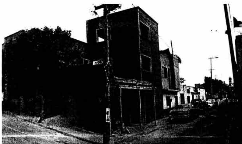
Vista de la construcción en el estado actual
