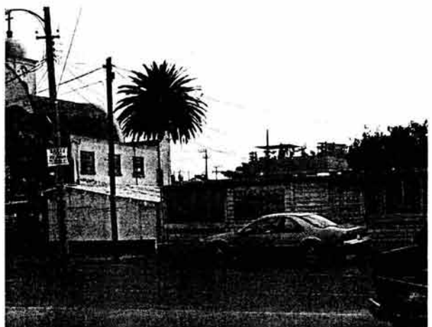
Centro de salud provisional, en deterioro
